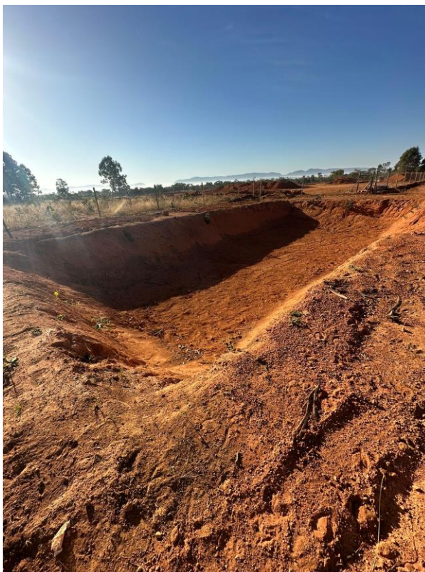
FOTO 1: LAGOA DE CONTENÇÃO
