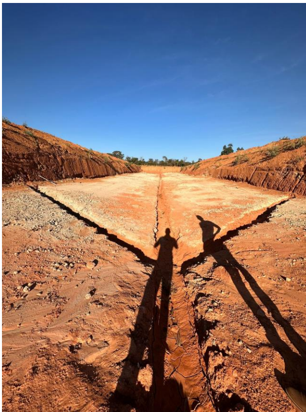
FOTO 4: CÉLULA DO ATERRO - DRENO
