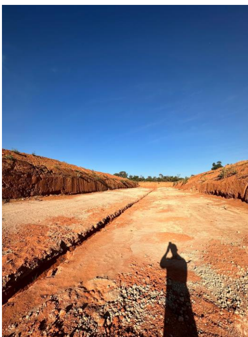
FOTO 6: CÉLULA DO ATERRO – DRENO
