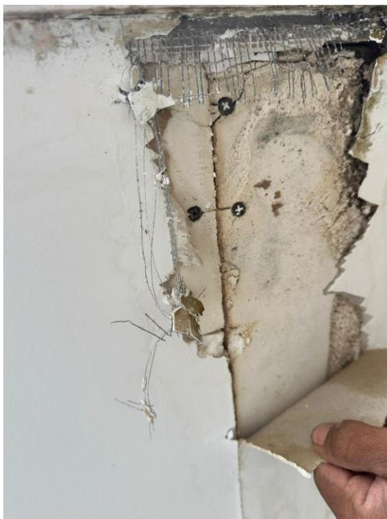
A execução do trabalho de recuperação de juntas no forro de Drywall, especialmente quando se substitui a fita de papel por fita telada de fibra de vidro, não
