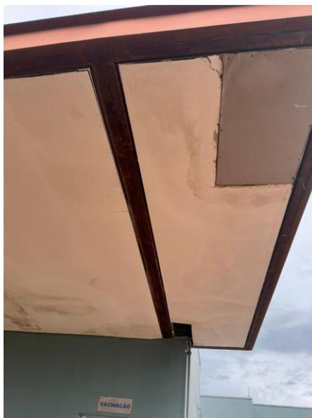
Essa correção é essencial para preservar a integridade estrutural e estética do sistema. Trincas podem comprometer a estabilidade das placas e, se não tratadas, resultar em danos mais graves. Deslocamentos podem levar ao desprendimento de placas, causando efeitos dominós prejudiciais.
