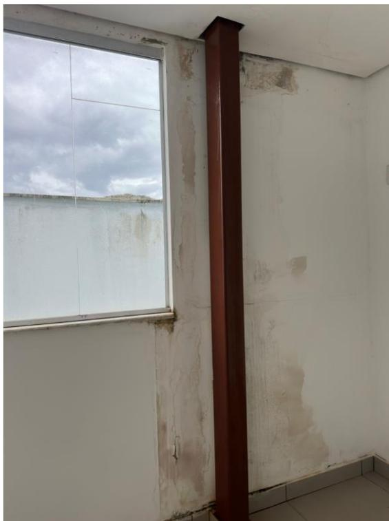
É fundamental abordar e tratar a umidade durante o processo de recuperação e manutenção de forro de Drywall por diversos motivos. A umidade, quando não controlada, pode comprometer a integridade estrutural do sistema, levando a problemas como o deslocamento das placas e o surgimento de mofo. Além disso, a umidade é uma causa comum de trincas e danos nas juntas do drywall.
