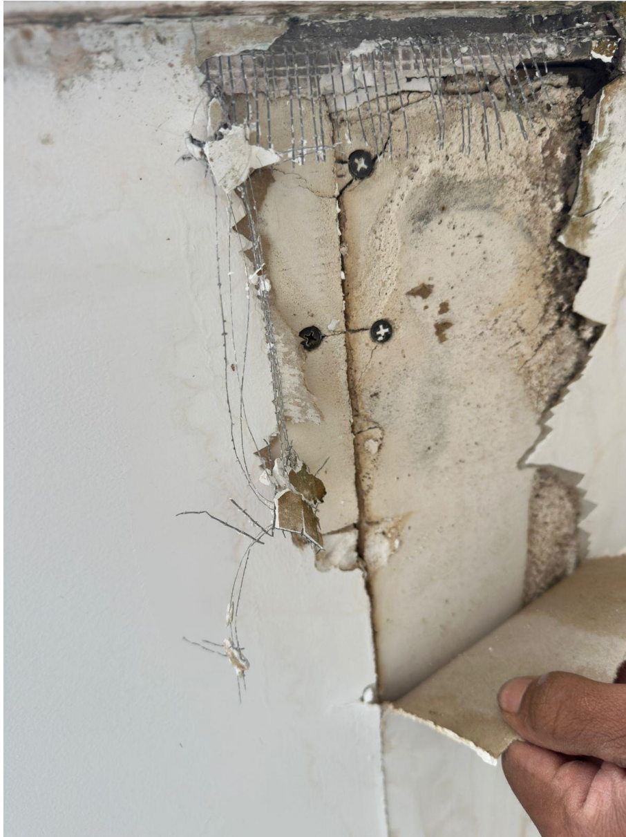
Foto 2: Juntas feitas com fita de papel, frágil e soltando nas emendas.
