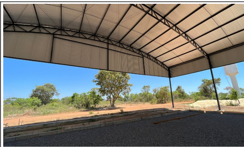
Descrição: Foto da vista do fundo da obra
